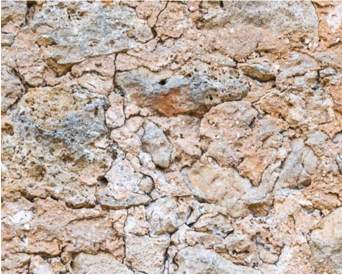
▲ Texture d'un enduit ancien de rejointoiment sur mur en dolomie.
