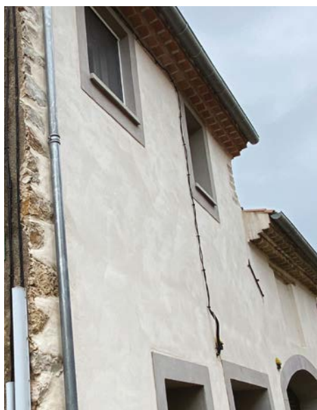
▲ Maisons du XIXe siècle, aux façades refaites au moyen d'un enduit prêt à l'emploi de finition talochée. Les encadrements saillants et ton sur ton avec la façade devraient être plus clairs car ils prennent plus la lumière et le parement devrait au contraire être plus foncé. Les raccords d'enduit inesthétiques auraient été évités avec une finition au mortier de chaux aérienne en pâte dont la prise est lente et par l'application d'un badigeon de chaux sur l'enduit.
