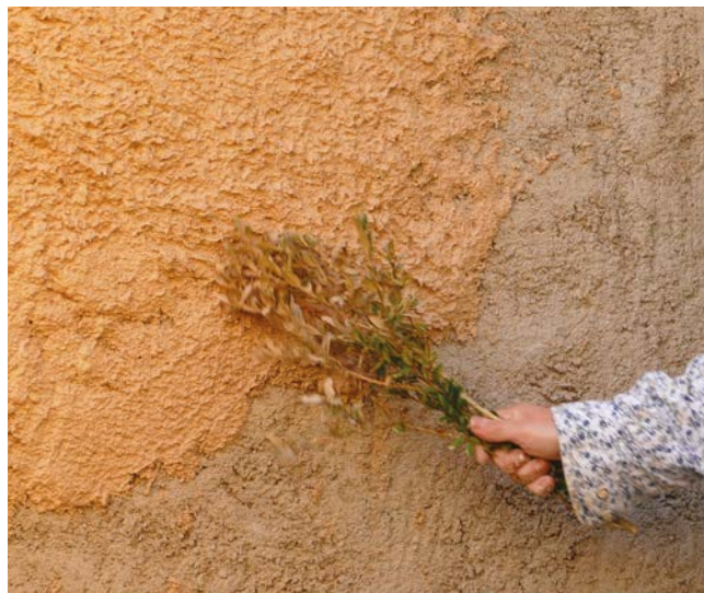
▲ Dressage et enduit de finition fouetté à la branche de buis (Journée de formation au château de Florac).
