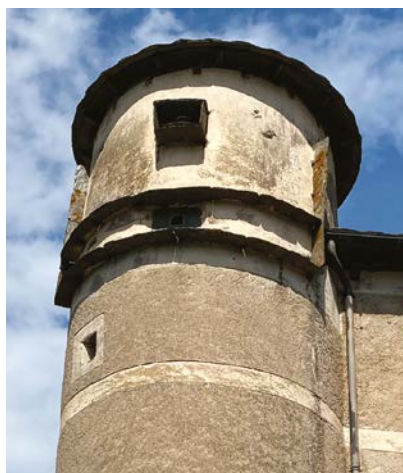
◀ Façade historique avec bandeaux horizontaux et enduits des deux tours colombiers lissés et peints en blanc, à conserver et restaurer (vallée Française).
