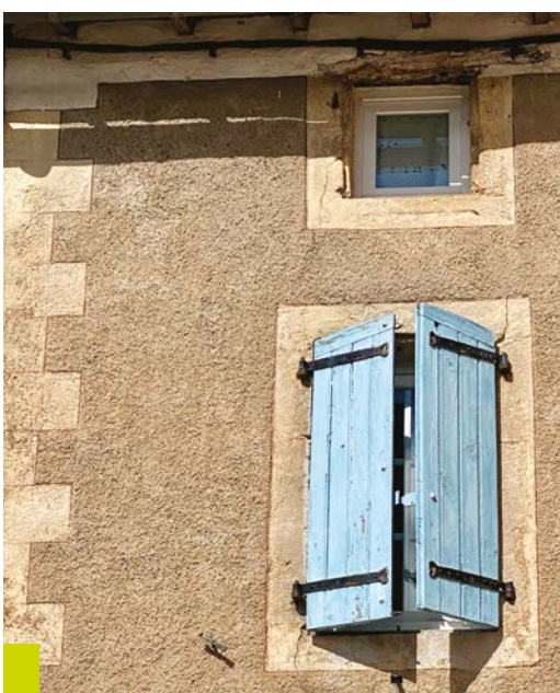
▲ Finition « jetée au balai » avec une alternance de texture et de couleur : le mur est « matiéré », la chaîne d'angle et les encadrements d'ouvertures sont lissés et peints à la chaux et soulignés d'un filet ocre rouge.
