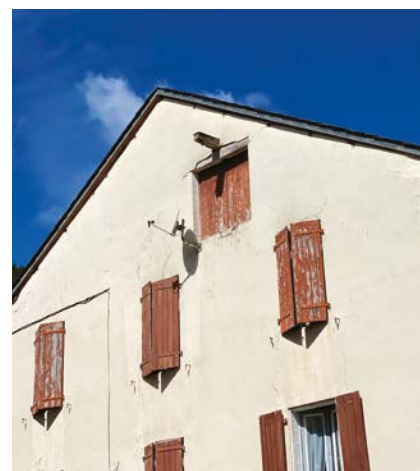
▲ Maisons du XIXe siècle, aux façades refaites au moyen d'un enduit prêt à l'emploi de finition talochée. Les encadrements saillants et ton sur ton avec la façade devraient être plus clairs car ils prennent plus la lumière et le parement devrait au contraire être plus foncé. Les raccords d'enduit inesthétiques auraient été évités avec une finition au mortier de chaux aérienne en pâte dont la prise est lente et par l'application d'un badigeon de chaux sur l'enduit.
