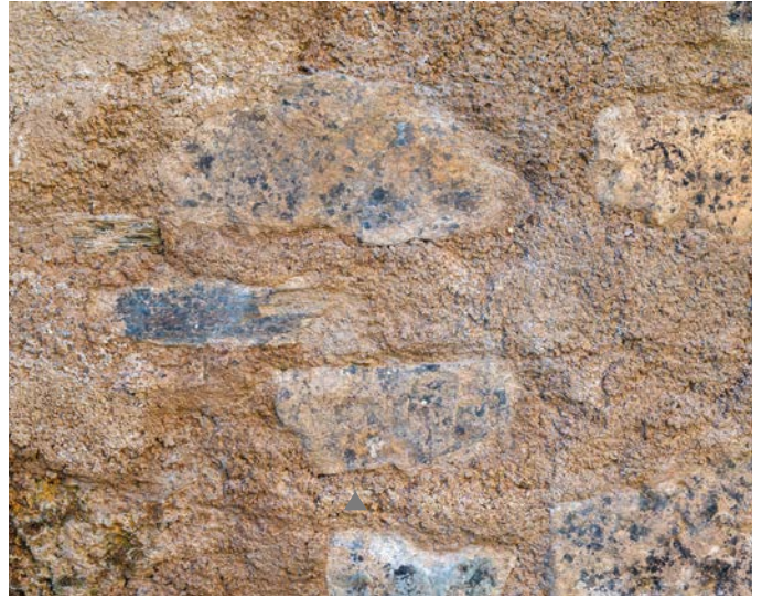
▲ Enduit de rejointoiment neuf, à fleur des têtes de pierres sur maçonnerie mixte (Journée de formation au château de Florac).
