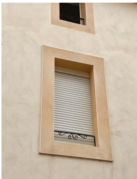
▲ Maisons du XIXe siècle, aux façades refaites au moyen d'un enduit prêt à l'emploi de finition talochée. Les encadrements saillants et ton sur ton avec la façade devraient être plus clairs car ils prennent plus la lumière et le parement devrait au contraire être plus foncé. Les raccords d'enduit inesthétiques auraient été évités avec une finition au mortier de chaux aérienne en pâte dont la prise est lente et par l'application d'un badigeon de chaux sur l'enduit.
