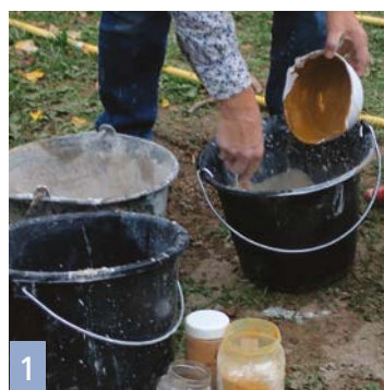
1. Préparation d'un badiage de chaux ocre jaune et terre d'ombre, pour obtenir un ton « pierre ».
